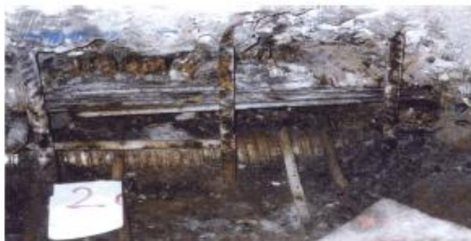
Corrosione in presenza di cloruri
