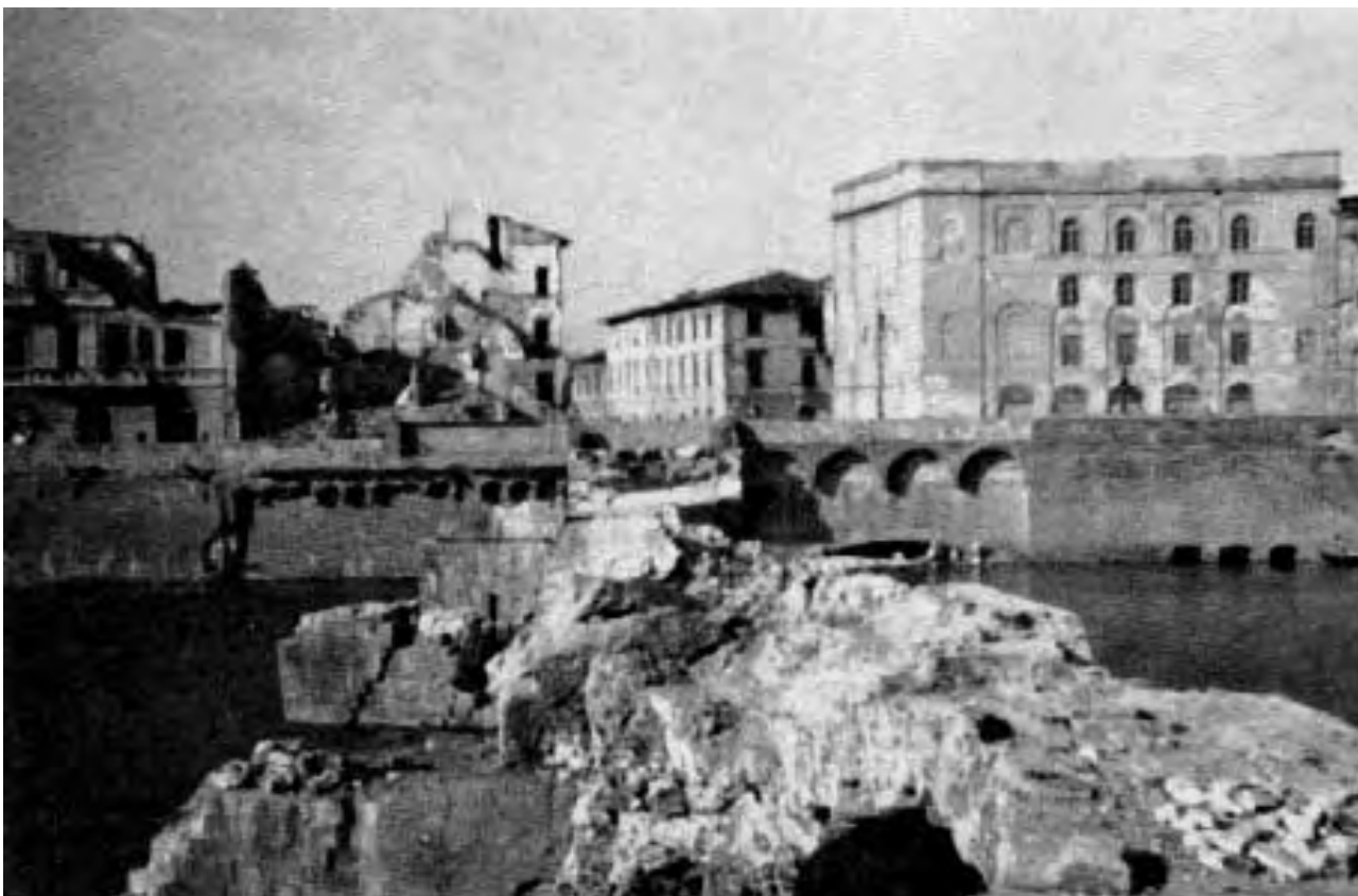
Il Ponte della Fortezza dopo le incursioni aeree.
