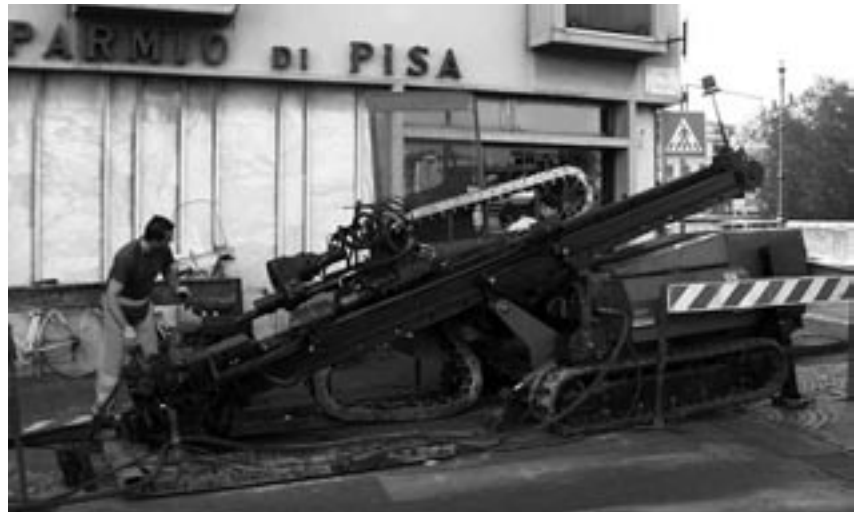
Una fase degli scavi per la realizzazione della rete.
