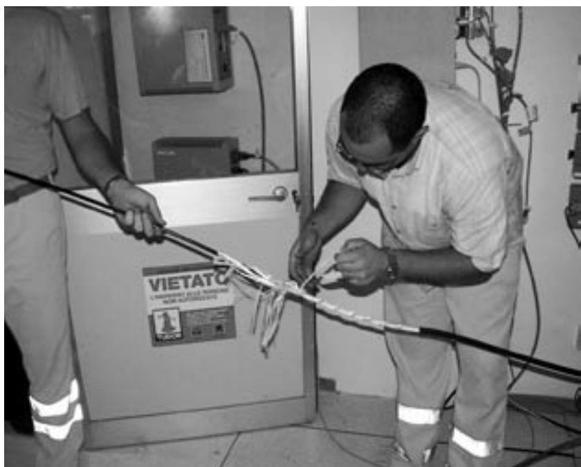
Preparazione della fibra per attestazione/giunzione.
