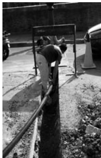
Una fase degli scavi per la canalizzazione della fibra ottica.
