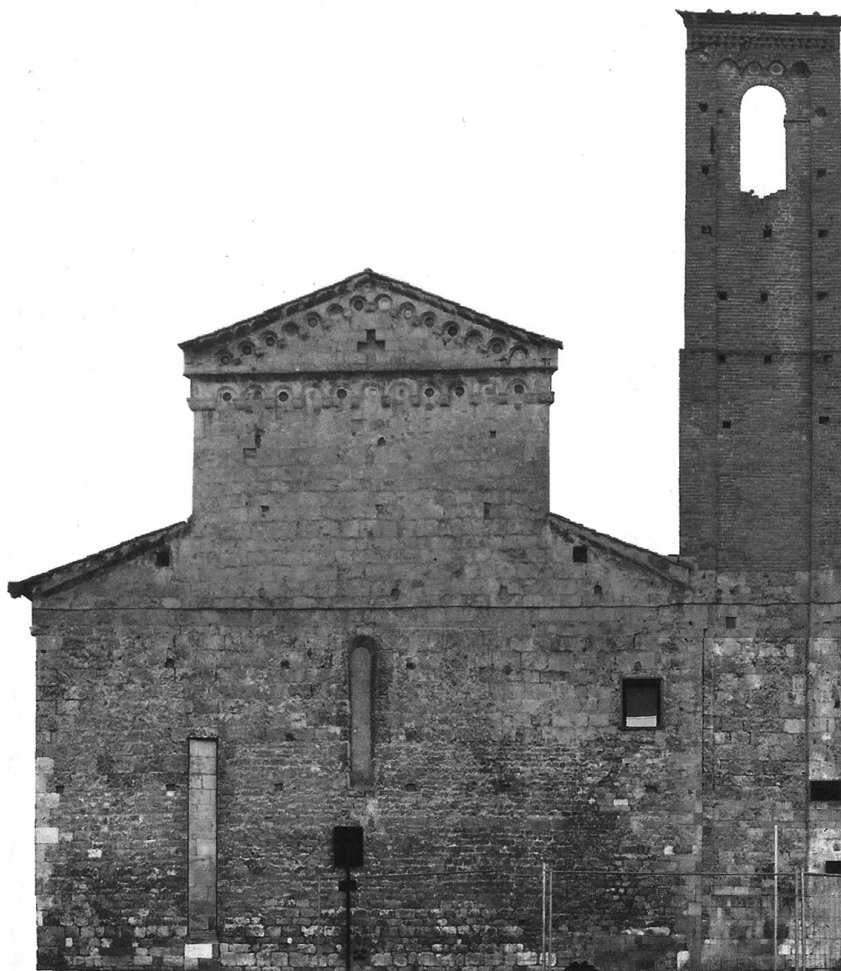
Immagine della parete posteriore della chiesa di S. Andrea realizzata con l'ausilio della fotogrammetria.
